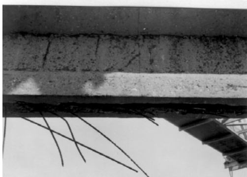
a) Teško oštećenje kablova kao posledica nepravilne zaštite još u fazi gradnje
