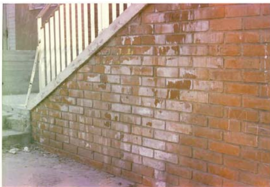
Slika 6 - Pojava »brašnjastog« raspadanja opeka usled dejstva hidratacionih i kristalizacionih pritisaka unutar pora
