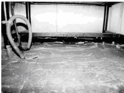
Slika 3 - Pojava podizanja pločica kao posledice sprečenog vlažnog širenja
