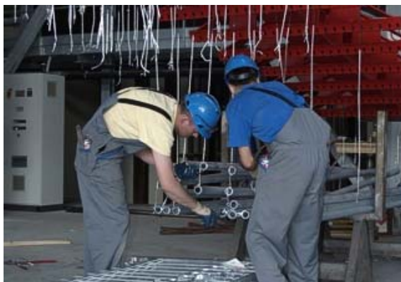
Skidanje elemenata sa greda
