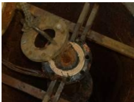
Slika 3 - Bunar Bnz-1 Trnovče izvlačenje potisnog cevovoda iz bunara
