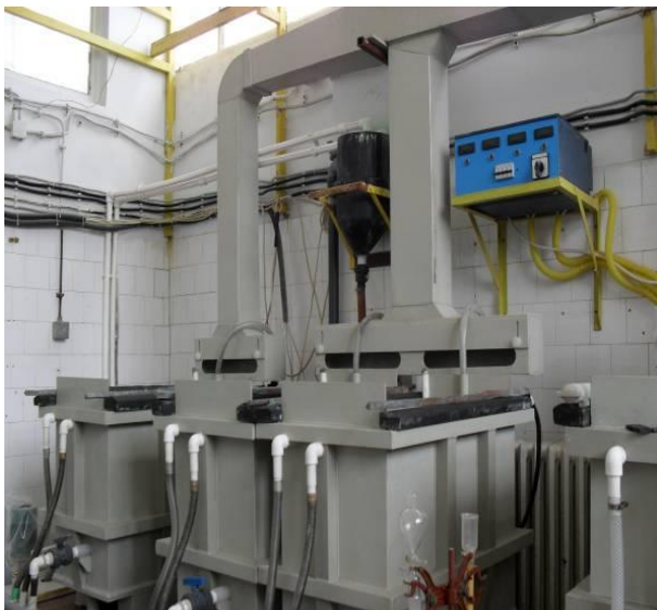
Slika 2 - Novo poluindustrijsko postrojenje za elektrolitičku rafinaciju bakarnih anoda nestandardnog hemijskog sastava - Linija I
